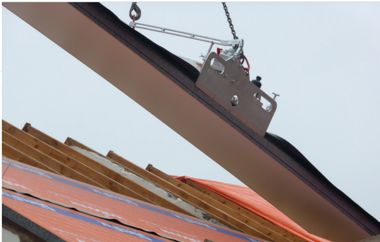
Te monteren met een HTZ dakplatenklem
